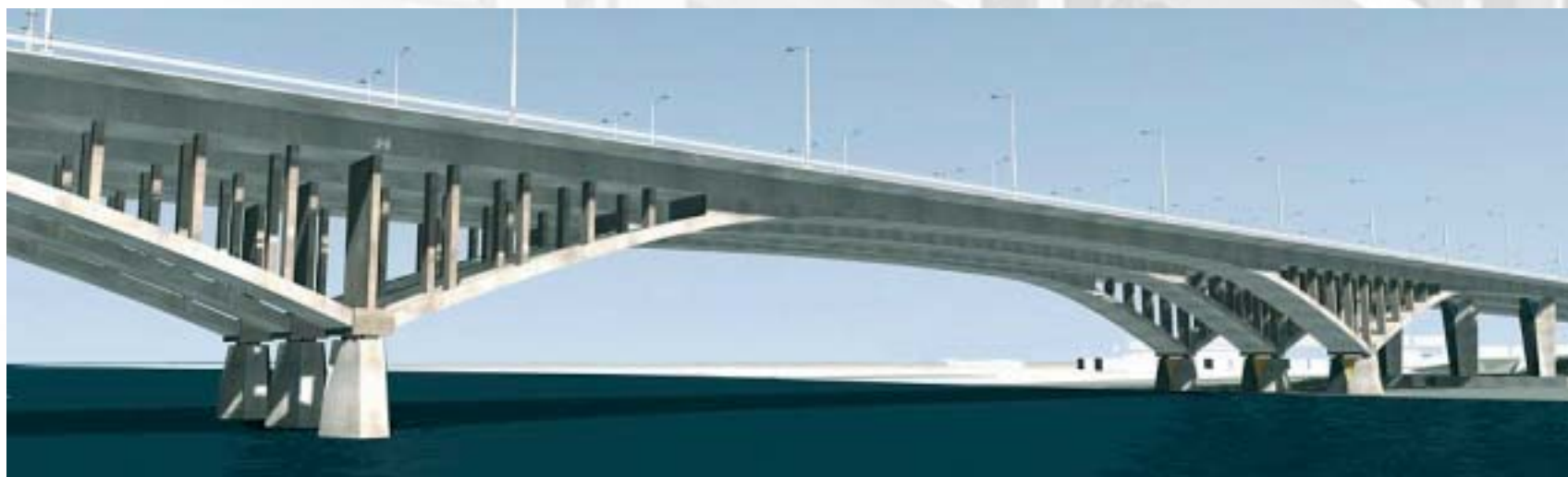
Projekt Mostu Północnego
